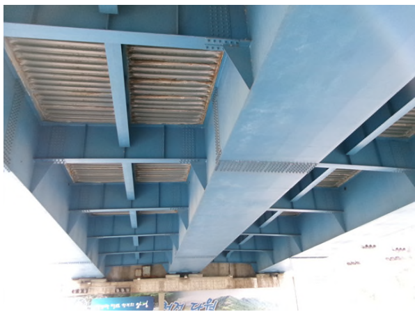
거더외부 및 바닥판 전경
