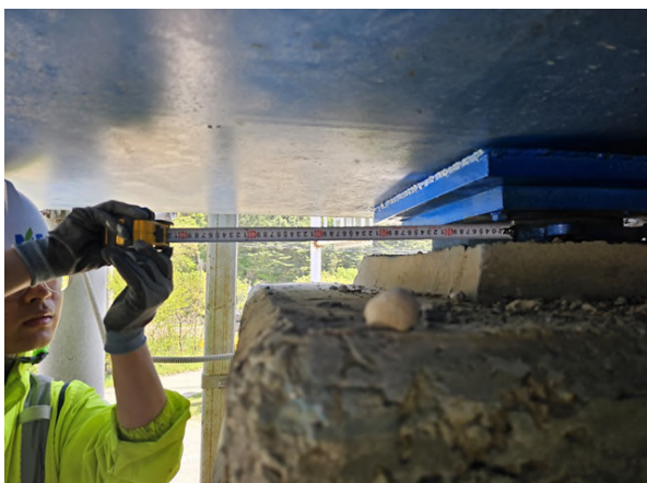
받침장치 연단거리 측정
